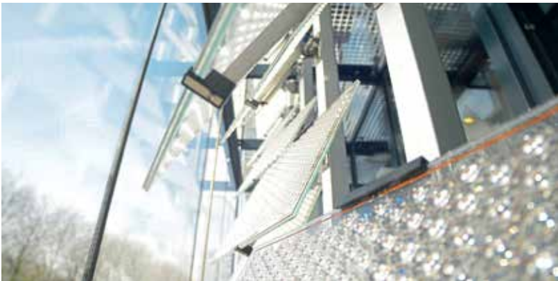
Lumiduct von Wellsun ermöglicht Glasfassaden, die mehr Energie erzeugen als konventionelle Fotovoltaikanlagen mit Silizium-Solarzellen.
