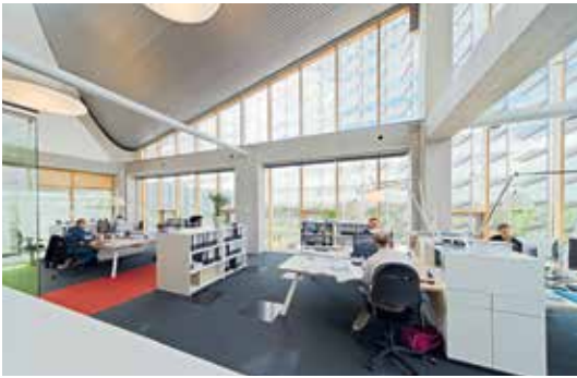
Helle Räume, angenehmes Klima: Die Solarmodule reduzieren die Blendwirkung an PC-Bildschirmen und halten die Hitze im Sommer fern.
