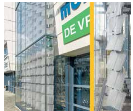
Pilotprojekt: Im niederländischen Alblasterdam sind die Solarmodule an dieser Fassade der Firma Mondial Movers verbaut.
